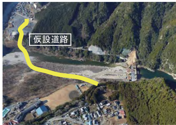
河川内仮設道路
