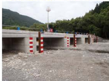
潜水橋完成状況(延長L=43.5m、幅員W=6.28m)
