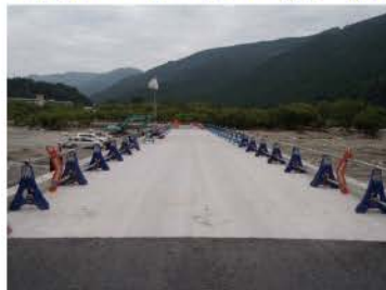
潜水橋完成状況(延長L=43.5m、幅員W=6.28m)
